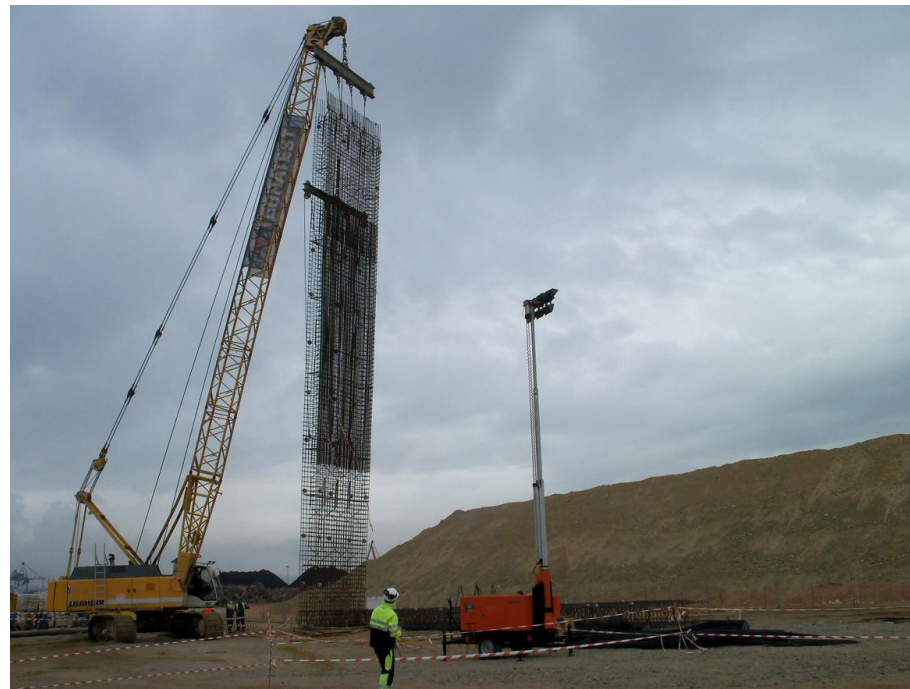
Ilustración 20. Introducción de jaula de armadura en panel de muro pantalla
